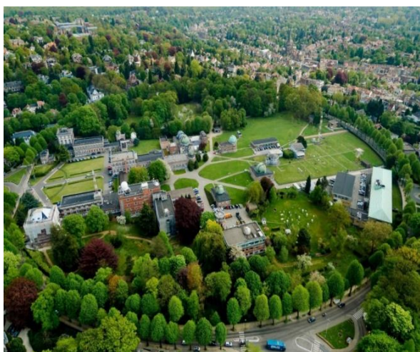
Foto 2. Overzicht site Ukkel vanuit de lucht
